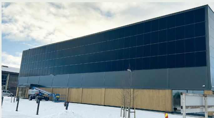
Det er Skanska som har hatt samspill- og totalentreprisen på prosjektet. Foto: Skanska/Amalie Jørvik
