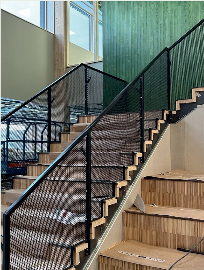
Trappeforbindelse mellom 1. og 2. etasje i skolebygget.
